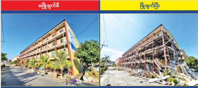
KKK Park နယ်မြေအပိုင်း(၃)တွင် တရားမဝင်ဆောက်လုပ်ထားသည့် လေးထပ်လူနေအဆောက်အအုံအား မဖြိုဖျက်မီနှင့် ဖြိုဖျက်ပြီးနောက် တွေ့ရစဉ်။
