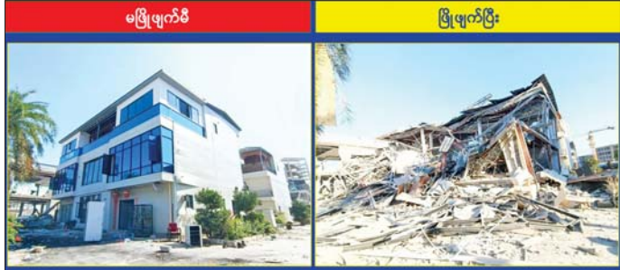
KK Park နယ်မြေအဝိုင်း(၃)တွင် တရားမဝင်အဆောက်အအုံများသည် သုံးထပ် လူနေအဆောက်အအုံအား မဖြိုဖျက်မီနှင့် ဖြိုဖျက်ပြီးနောက် တွေ့ရစဉ်။
