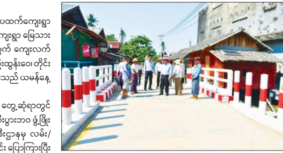
ဆက်လမ်းပေါ်ရှိ ကျောက်ကြီးစီသံကုက္ကနကရစ်တံတားနှင့် တံတားချင်းကပ်လမ်း ပြင်ဆင်ထိန်းသိမ်းခြင်းလုပ်ငန်းတည်ဆောက်နေမှုကို ကြည့်ရှုစစ်ဆေးခဲ့ကြောင်း သိရသည်။
