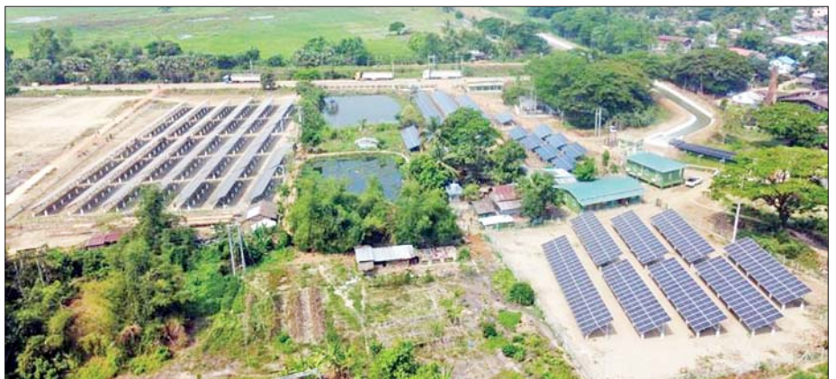
တိုက်ကြီးမြို့နယ် တော်လတီကျေးရွာရှိ ဆိုလာစနစ်သုံး သပြေတန်းမြစ်ရေတင်လုပ်ငန်းကို တွေ့ရစဉ်။
