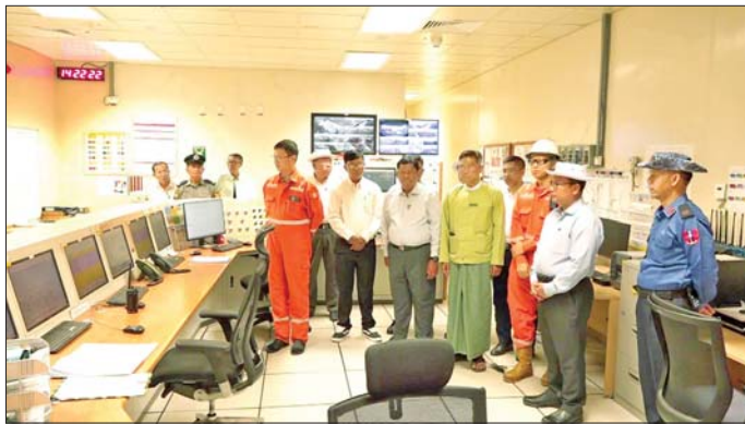
ဆက်လက်၍ ဂုံးချိုကျေးရွာအနီး ကုန်းတွင်း သဘာဝဓာတ်ငွေ့လက်ခံရေးစခန်း (Internal Gas Station - IGS) သို့ သွားရောက်၍ သိရှိလိုသည်များကို လှည့်လည်မြန်းဆွေးနွေးကာ လုပ်ငန်းခွင်ကို လှည့်လည်ကြည့်ရှု စစ်ဆေးခဲ့ကြောင်း သိရသည်။ တင်ထွန်း (ပြန်/ဆက်)
