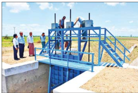
မုန်းမြောင်းမကြီး လက်တံ (၁၀)ခွက် အတွက် ရေတံခွက် အဆင့်မြှင့်တင်ရေးအတွက် တည်ဆောက်နေသော ရေမြင့်အဆောက်အအုံ
