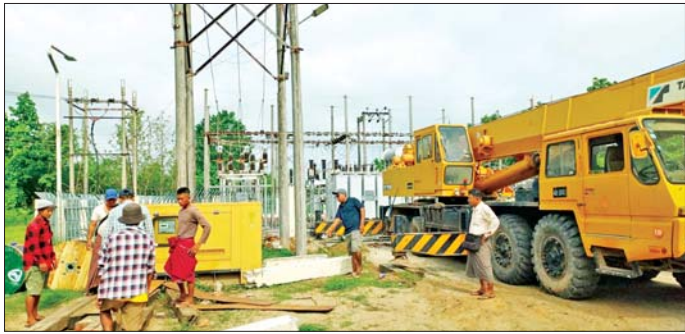
ဥတ္တရသီရိမြို့နယ် ၃၃ ကေပီ ဓာတ်အားခွဲရုံ အမှတ်(၂)ရှိ ၃၃/၁၁ ကေပီ၊ ၁၀ အမ်ပီအေ ထရန်စဖော်မာ အား အစားထိုးလဲလှယ်ခြင်းလုပ်ငန်း ဆောင်ရွက်စဉ်။
