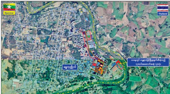
ကရင်ပြည်နယ် မြဝတီမြို့နယ် ရွှေကုက္ကိုလ်ဒေသရှိ တရားမဝင်အဆောက်အအုံများကို ဖောက်ခွဲဖျက်ဆီးမှု။
