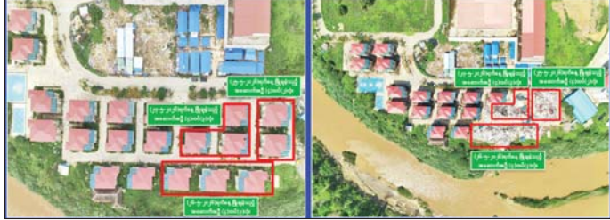
ကရင်ပြည်နယ် မြဝတီမြို့နယ် ရွှေကုက္ကိုလ်ဒေသ အွန်လိုင်းလိမ်လည်လောင်းကစားလုပ်ငန်းလုပ်ကိုင်ခဲ့သော အဆောက်အအုံများကို မဖြိုဖျက်မီနှင့် ဖြိုဖျက်ပြီးနောက် တွေ့ရပုံ။
