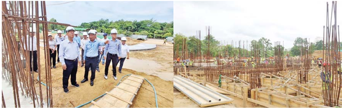
နှစ်ထပ်အဆောက်အအုံအသစ်ဆောက်လုပ်နေမှုနှင့် ဆောက်လုပ်ပြီးစီးမှုအခြေအနေများကို ရှင်းလင်းတင်ပြကြရာ နိုင်ငံတော်ဖွဲ့စည်းပုံအခြေခံဥပဒေဆိုင်ရာခုံရုံးဥက္ကဋ္ဌ က တည်ဆောက်ရေးလုပ်ငန်းများတွင် အသုံးပြုမည့်ပစ္စည်းများကို သတ်မှတ်ထားသော စံချိန်စံညွှန်းများနှင့်အညီ မြေလျင်ပြင်းအား ၈ မဂ္ဂနီကျူအထိ ခံနိုင်ရည်ရှိစေရန် အရည်အသွေးပြည့်မီစွာ
