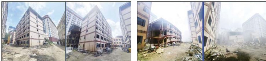
ကရင်ပြည်နယ် ရွှေကုက္ကိုလ်နယ်မြေရှိ အွန်လိုင်းလိမ်လည်လောင်းကစားမူလုပ်ကိုင်ခဲ့သည့် တရားမဝင် ခုနစ်ထပ်လူနေအဆောက်အအုံအား ယမ်းဖြင့် မဖောက်ခွဲမီ (ဝဲဘက်) နှင့် ဖောက်ခွဲဖျက်ဆီးပြီး (ယာဘက်) ကို တွေ့ရစဉ်။
