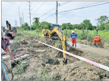
လေးလက်မ သဘာဝဓာတ်ငွေ့ပိုက်လိုင်း ယိုစိမ့်မှုအား ပြုပြင်ခြင်းလုပ်ငန်းဆောင်ရွက်နေသည့် မှတ်တမ်းဓာတ်ပုံများ။
