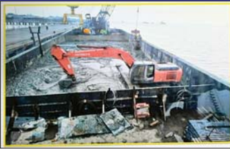
ကျားပစ်သောင်တူးရေယာဉ် M.V.Mercury Force ဖြင့် သောင်တူးဖော်ခြင်း
