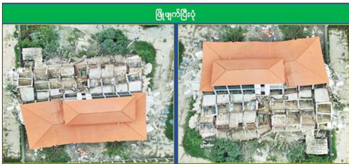
ကရင်ပြည်နယ် မြောက်မြို့နယ် ရွှေကုက္ကိုလ်နယ်မြေရှိ အွန်လိုင်းလိမ်လည်လောင်းကစားမှု လုပ်ကိုင်ခဲ့သည့် တရားမဝင် ကိုးထပ်အဆောက်အအုံကို ဖြိုချဖျက်ဆီးမှု တွေ့ရစဉ်။
