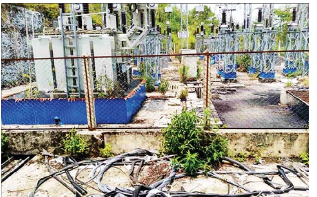
၆၆/၁၁ ကေစီ ၅ အမ်စီအေ ဖလမ်းဓာတ်အားခွဲရုံ ပျက်စီးဆုံးရှုံးခဲ့မှု မှတ်တမ်းဓာတ်ပုံ။
