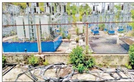
၆၆/၁၁ ကေစီ ၅ အမီစီအေ ဖလမ်းဓာတ်အားခွဲရုံ ပျက်စီးဆုံးရှုံးခဲ့ မှတ်တမ်းဓာတ်ပုံ။
