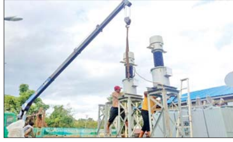
နောင်ချိုမြို့နယ် ၃၃/၁၁ ကေစီ ၁၀ အမီစီအေ ရွှေညောင်ပင် ဓာတ်အားခွဲရုံတွင် ပျက်စီးနေသော ဓာတ်အားခွဲရုံပစ္စည်းများ ပြုပြင် နေမှု မှတ်တမ်းဓာတ်ပုံ။
