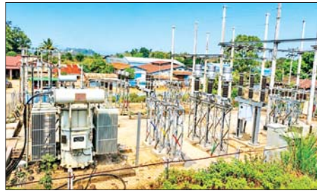
သီပေါမြို့နယ် ၃၃/၁၁ ကေစီ ၁၀ အမီစီအေ သီပေါဓာတ်အားခွဲရုံ တွင် ပျက်စီးနေသော ဓာတ်အားခွဲရုံပစ္စည်းများ အသစ်အစားထိုး ပြုပြင်တည်ဆောက်ခြင်း မှတ်တမ်းဓာတ်ပုံ။
