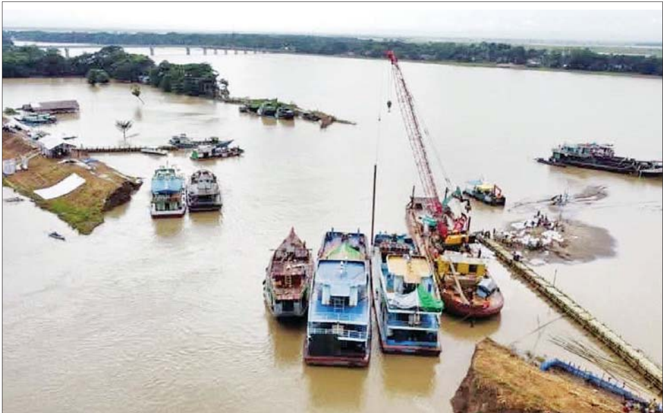
ငဝန်မြစ် ရေကာတာ တာတမံခိုမိကျမှုကြောင့် ရေတိုက်စားမှုကာကွယ်ခြင်းနှင့် ရေနက်ရေစီးကြောင်း ပိတ်ဆို့နိုင်ရေး လုပ်ငန်းဆောင်ရွက်နေမှုကို တွေ့ရစဉ်။
