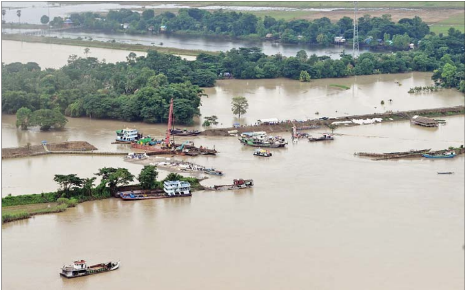
ငဝန်မြစ် ရေကာတာ တာတမံခိုမိကျမှုကြောင့် ရေတိုက်စားမှုကာကွယ်ခြင်းနှင့် ရေနက်ရေစီးကြောင်း ပိတ်ဆို့နိုင်ရေး လုပ်ငန်းဆောင်ရွက်နေမှုကို တွေ့ရစဉ်။
