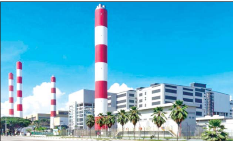
စင်ကာပူနိုင်ငံ၏ နည်းပညာအခြေပြုစီမံခန့်ခွဲမှု Waste to Energy (WTE) ခေါ် အမှိုက်မီးရှို့ပြီး လျှပ်စစ်ဓာတ်အား ထုတ်ယူသည့် စက်ရုံကြီးများ။
