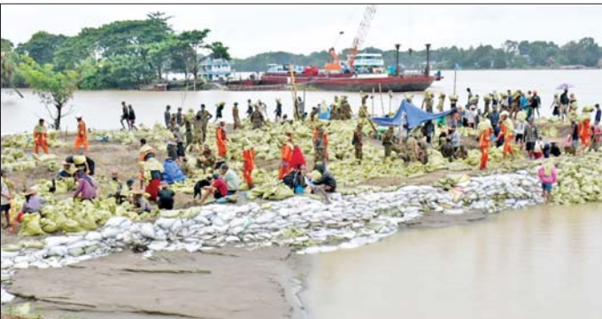
ဟင်္သာတခရိုင် လေးမျက်နှာမြို့နယ် ငဝန်တာနိမ့်ကျမှုအပေါ် ရေဝင်လမ်းကြောင်းပိတ်ဆို့နိုင်ရေး လုပ်ငန်းများ ဆောင်ရွက်နေမှုကို တွေ့ရစဉ်။
