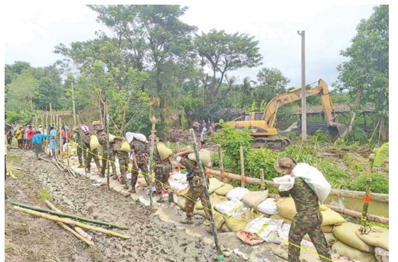
နယ်မြေခံတပ်မတော်သားများ၊ မြန်မာနိုင်ငံရဲတပ်ဖွဲ့ဝင်များ၊ လူမှုရေးအသင်းအဖွဲ့ များနှင့်ဒေသခံပြည်သူများပူးပေါင်း၍ ညောင်တုန်းကျွန်းတာ(ရောဂါတိမြစ်ခွဲ)၌ တာကိုယ်ထည်တိုက်စားခံရမှု တားဆီးကာကွယ်ရေးလုပ်ငန်းများဆောင်ရွက်စဉ်။
