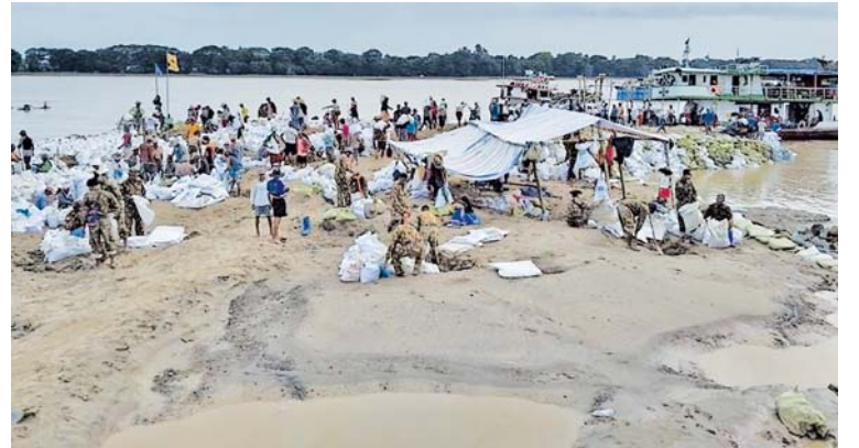
အနောက်တောင်တိုင်းစစ်ဌာနချုပ်မှ နယ်မြေခံတပ်မတော်သားများက ငဝန်ပန်းတာရေဝင်ရောက်မှုကို ထိန်းချုပ်ကာကွယ်နိုင်ရန်အတွက် Geobags သဲအိတ်ကြီးများချ၍ ကာကွယ်ခြင်းဆောင်ရွက်စဉ်။
