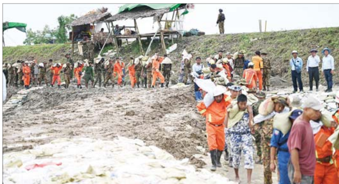
ဧရာဝတီတိုင်းဒေသကြီး ညောင်တုန်းမြို့နယ် ဂန်ချောင်းကျေးရွာအနီး ညောင်တုန်းကျွန်းတာ(ဧရာဝတီမြစ်ခွဲ)တာကိုယ်ထည် ရေတိုက်စားခံရမှု ယာယီတားဆီးကာကွယ်ရေးလုပ်ငန်းများ ဆောင်ရွက်နေမှုကို တွေ့ရစဉ်။
