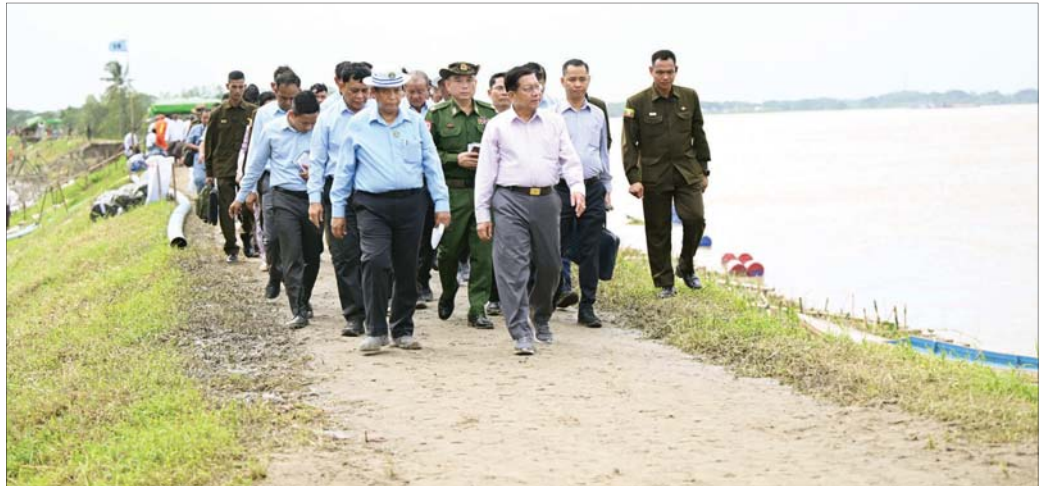
နိုင်ငံတော်သမ္မတ ဦးမင်းအောင်လှိုင် ဧရာဝတီတိုင်းဒေသကြီး ညောင်တုန်းမြို့နယ် ဂန်ချောင်းကျေးရွာအနီး ညောင်တုန်းကျွန်းတာ(ဧရာဝတီမြစ်ခွဲ)တာကိုယ်ထည် ရေတိုက်စားခံရမှု ယာယီတားဆီးကာကွယ်ရေးလုပ်ငန်းများဆောင်ရွက်နေမှုများကို ကြည့်ရှုစစ်ဆေးစဉ်။
