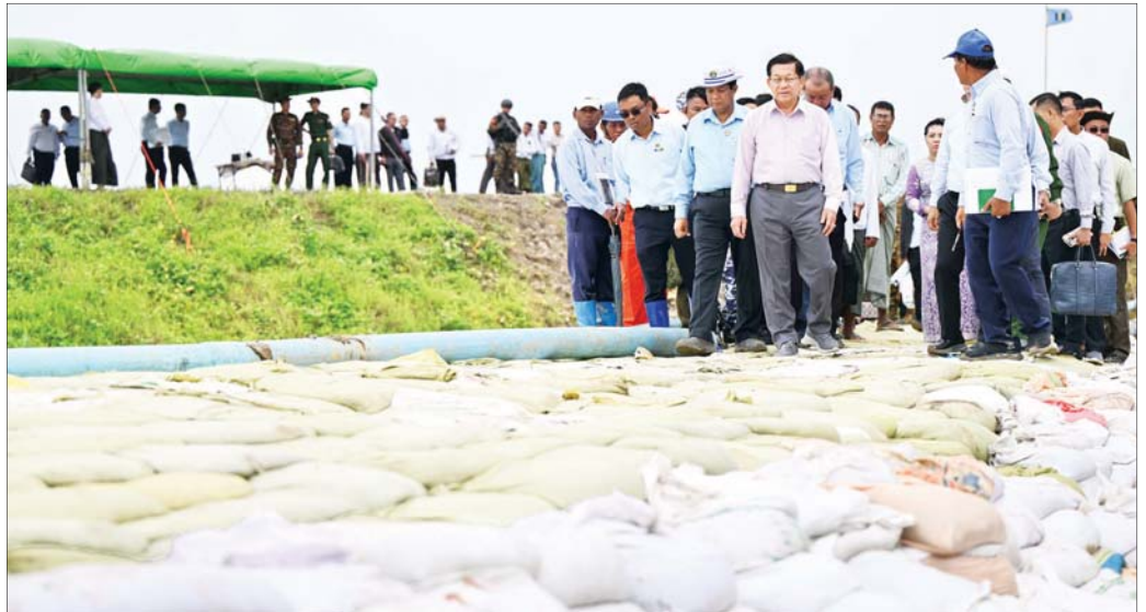
နိုင်ငံတော်သမ္မတ ဦးမင်းအောင်လှိုင် ဧရာဝတီတိုင်းဒေသကြီး ညောင်တုန်းမြို့နယ် ဂန့်ချောင်းကျေးရွာအနီး ညောင်တုန်းကျွန်းတာ(ဧရာဝတီမြစ်ခွဲ)တာကိုယ်ထည် ရေတိုက်စားခံရမှု ယာယီတားဆီးကာကွယ်ရေးလုပ်ငန်းများဆောင်ရွက်နေမှုများကို ကြည့်ရှုစစ်ဆေးစဉ်။
