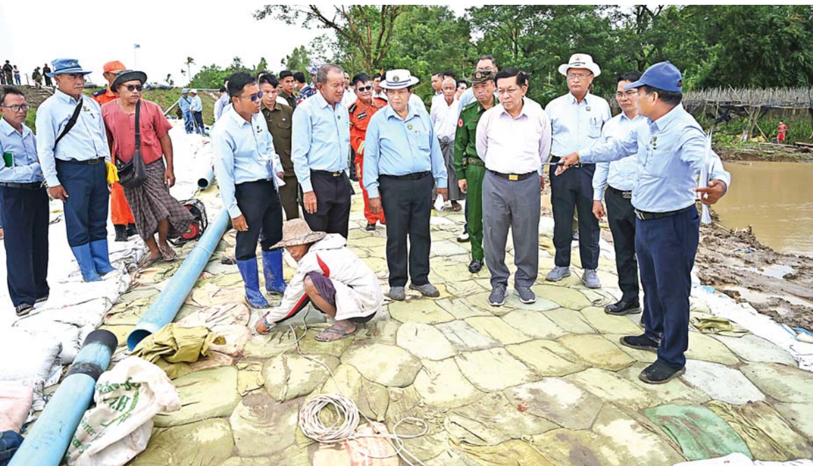
နိုင်ငံတော်သမ္မတ ဦးမင်းအောင်လှိုင် ဧရာဝတီတိုင်းဒေသကြီး၊ ညောင်တုန်းမြို့နယ် ဂန်ချောင်းကျေးရွာအနီး ညောင်တုန်းကျွန်းတာ (ဧရာဝတီမြစ်ခွဲ)တာကိုယ်ထည်ရေတိုက်စားခံရမှု တားဆီးကာကွယ်ရေးလုပ်ငန်းများဆောင်ရွက်နေမှုကို ကြည့်ရှုစစ်ဆေးစဉ်။
