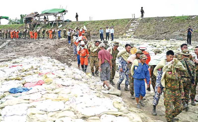
ဧရာဝတီတိုင်းဒေသကြီး၊ ညောင်တုန်းမြို့နယ် ဂန်ချောင်းကျေးရွာအနီး ညောင်တုန်းကျွန်းတာ(ဧရာဝတီမြစ်ခွဲ) တာကိုယ်ထည်ရေတိုက်စားခံရမှုတားဆီးကာကွယ်ရေးလုပ်ငန်းများဆောင်ရွက်နေမှုကို တွေ့ရစဉ်။
