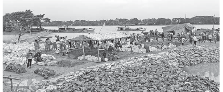
အနောက်တောင်တိုင်းစစ်ဌာနချုပ်မှ နယ်မြေခံတပ်မတော်သားများက ငဝန်ပန်းတာရေဝင်ရောက်မှုထိန်းချုပ်ကာကွယ်နိုင်ရန်အတွက် သဲအိတ်များဖြည့်၍ကာကွယ်ခြင်း ဆောင်ရွက်ပေးစဉ်။
