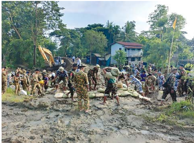
နယ်မြေခံတပ်မတော်သားများ၊ မြန်မာနိုင်ငံရဲတပ်ဖွဲ့ဝင်များ၊ လူမှုရေးအသင်းအဖွဲ့များနှင့်ဒေသခံပြည်သူများပူးပေါင်း၍ ညောင်တုန်းကျွန်းတာ (ရောဝတီမြစ်ခွဲ) တာကိုယ်ထည်တိုက်စားခံရမှု တားဆီးကာကွယ်ရေးလုပ်ငန်းများဆောင်ရွက်စဉ်။
