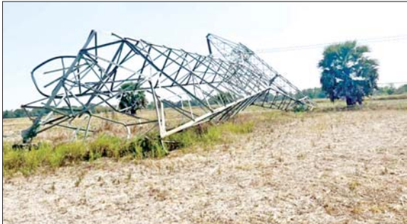
၂၃၀ ကေစီ ရွှေ့ကျင် - သာယာကုန်း ဓာတ်အားလိုင်း ဖျက်ဆီးခံရမှုကြောင့် ပြိုလဲပျက်စီးလျက်ရှိသည့် တာဝါတိုင် (ဝဲပုံ)နှင့် ဓာတ်အားလိုင်းပြုပြင်ပြီးစီးမှု (ယာပုံ) တို့ကို တွေ့ရစဉ်။
