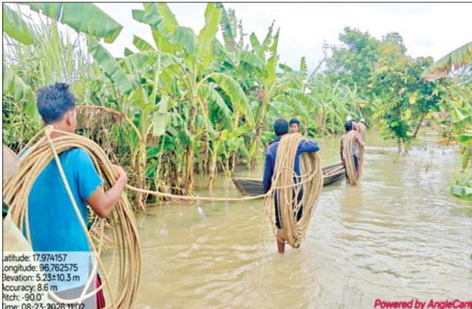
၂၃၀ ကေစီ ရွှေကျင် - သာယာကုန်း ဓာတ်အားလိုင်းပြုပြင်ခြင်းလုပ်ငန်း ဆောင်ရွက်နေမှုကို တွေ့ရစဉ်။
