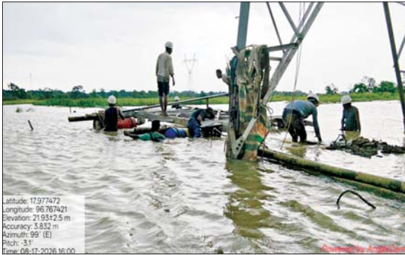
၂၃၀ ကေစီ ရွှေ့ကျင် - သာယာကုန်း ဓာတ်အားလိုင်း ပြုပြင်ခြင်းလုပ်ငန်း ဆောင်ရွက်နေမှုကို တွေ့ရစဉ်။
