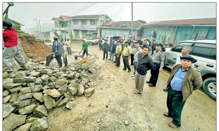
တန်းကျောင်းခွဲ၊ လွယ်ဘွား ဘေးနှင့် စည်ပင်သာယာရေး ရေးဆောင်ရွက်ခဲ့ကြောင်း သိရ ရပ်ကွက် ကမ်းဟောက်လမ်းမကြီး အဟောင်းတို့တွင် စုပေါင်းသန့်ရှင်း သည်။ သတင်းစဉ်
