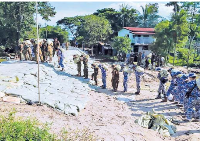
နယ်မြေခံတပ်မတော်သားများ၊ မြန်မာနိုင်ငံရဲတပ်ဖွဲ့ဝင်များ၊ လူမှုရေးအသင်းအဖွဲ့များနှင့် ဒေသခံပြည်သူများပူးပေါင်း၍ ညောင်တုန်းကျွန်းတာ(ဧရာဝတီမြစ်ခွဲ) တာကိုယ်ထည်တိုက်စားခံရမှုတားဆီးကာကွယ်ရေးလုပ်ငန်းများဆောင်ရွက်စဉ်။
