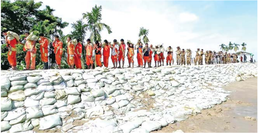
နယ်မြေခံတပ်မတော်သားများ၊ မြန်မာနိုင်ငံရဲတပ်ဖွဲ့ဝင်များ၊ မီးသတ်တပ်ဖွဲ့ဝင်များ၊ လူမှုကူညီရေးအဖွဲ့များ၊ ပရဟိတအသင်းအဖွဲ့များနှင့် ဒေသခံတိုင်းရင်းသားများပူးပေါင်း၍ ညောင်တုန်းကျွန်းတာ(ဧရာဝတီမြစ်ခွဲ) တာကိုယ်ထည်တိုက်စားခံရမှု တားဆီးကာကွယ်ရေးလုပ်ငန်းများဆောင်ရွက်စဉ်။
