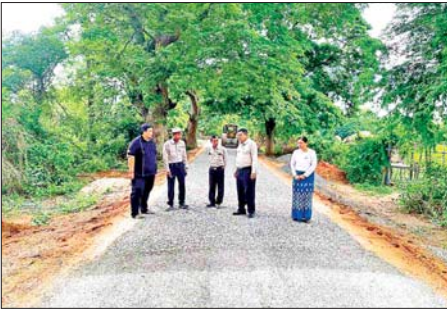
ကတ္တရာလမ်းခင်းခြင်းလုပ်ငန်း ဆောင်ရွက်နေမှု တာဝန်ရှိသူများ ကွင်းဆင်းစစ်ဆေး
