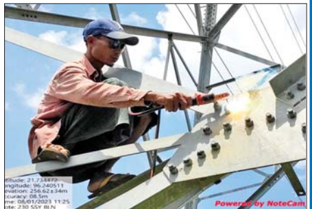
သံပေါင်များ၊ ဘိုနပ်များ ခိုးယူခြင်းမခံရစေရန်အတွက် ဂဟေဆော်၍ တွဲဆက်နေမှုကို တွေ့ရစဉ်။
